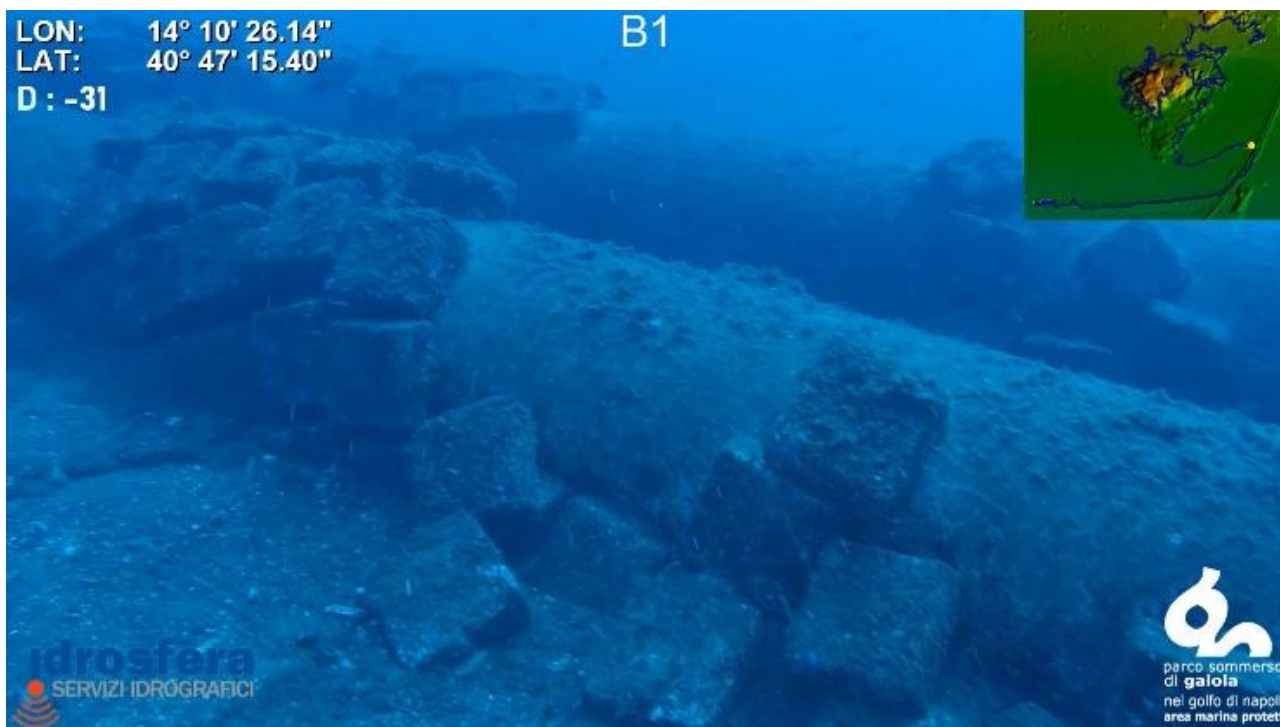
Fig. 43 Condotta di scarico fognario sfociante nei pressi della Secca della Badessa con cuscini in calcestruzzo disgregati
